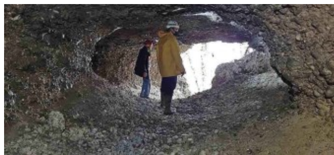
La galleria presenta alcuni colassamenti delle pareti e la sezione trasversale assume la forma da rettangolare ad ellittica.
