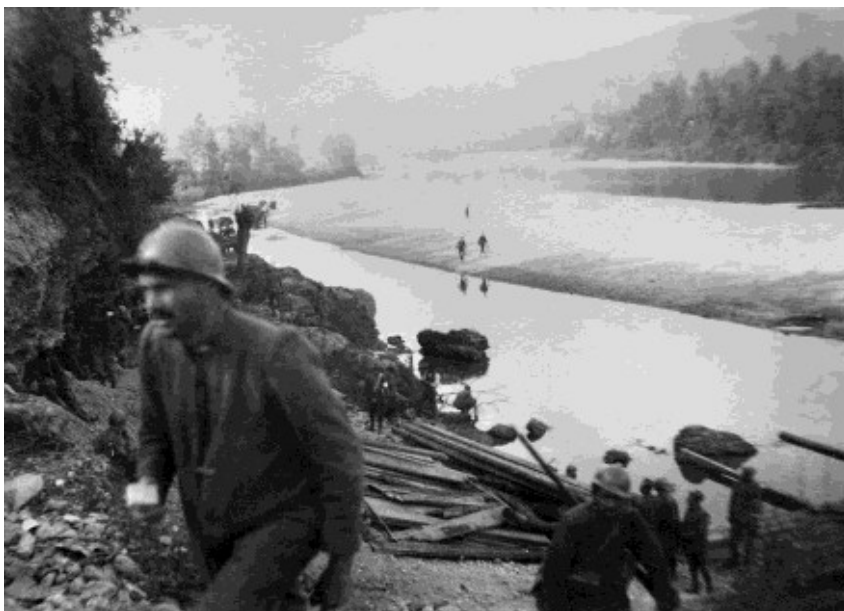
Subito dopo la presa di Gorizia ricostruzione della passerella nei cui pressi si trova il graffito a.u.
