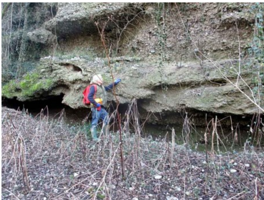
Fig. 6 - Evidenti segni di erosioni fluviali al piede della scarpata.
