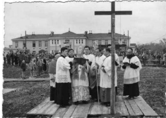
19 aprile 1959. La posa della prima pietra della costruenda nuova chiesa della Campagnuzza. Io sono tra i ragazzi che si vedono sulla sinistra della foto.
