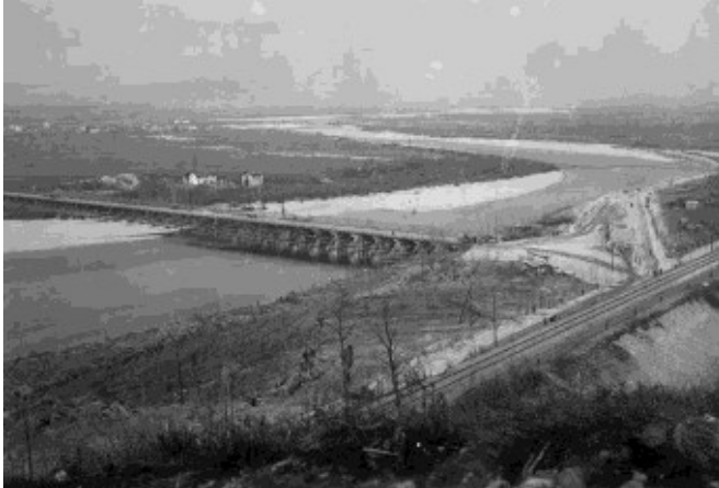
La testata sulla riva sinistra del ponte che univa Peteano a Farra.
