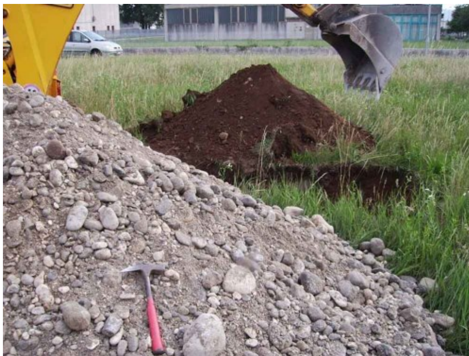
Fig. 8 - Esecuzione di uno scavo geognostico presso la zona industriale di S. Andrea. In primo piano le ghiaie sabbiose sciolte (GS). Subito dietro, il cumulo scuro di terreno limoso-argilloso che costituisce lo strato di alterazione superficiale.
