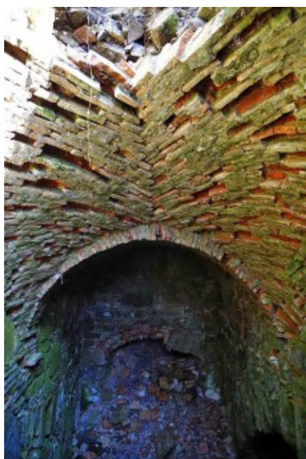
La volta dell'ingresso alle cantine di Villa Fausta.
