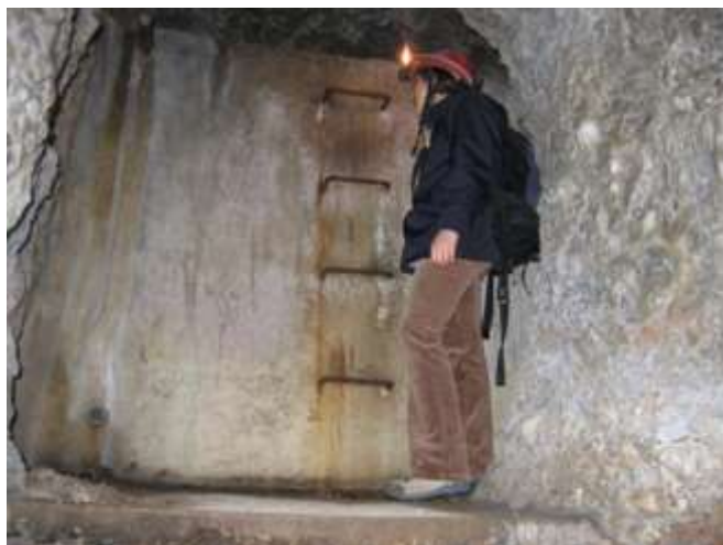
Fig. 51 – All'interno della galleria si trova una grande vasca in cemento che serviva per la raccolta dell'acqua.
