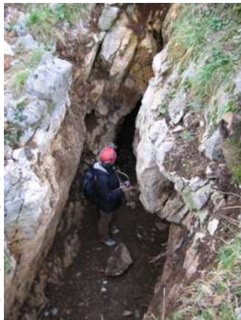
Fig. 50 – L'ingresso della "Galleria dell'Acqua" dopo una prima pulizia del materiale accumulato negli anni.
