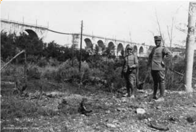
Fig. 17 – Il ponte ferroviario sull'Isonzo nei pressi di Gorizia subito dopo la presa della città. Dopo la conquista di Gorizia tutte le linee ferroviarie risultarono estremamente danneggiate (Archivio V. Aprato - Torino).
