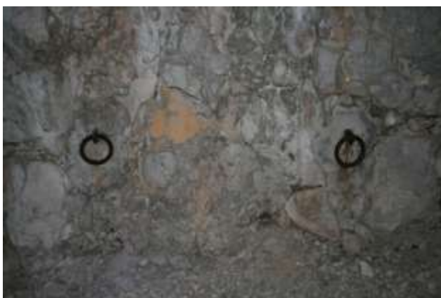
Fig. 37 – Gli anelli in ferro che servivano per far scendere i cannoni e le loro munizioni. Sono ancora presenti lungo tutta la galleria.
