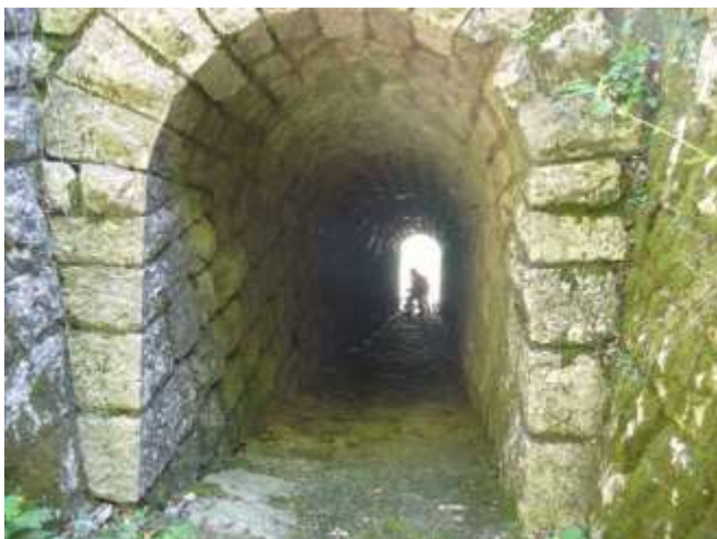
Fig. 11 – Nella massicciata della Ferrovia Meridionale, in posizione antistante l'ingresso della risorgiva è stato costruito questo grande canale di deflusso delle acque provenienti dalla risorgiva stessa.
