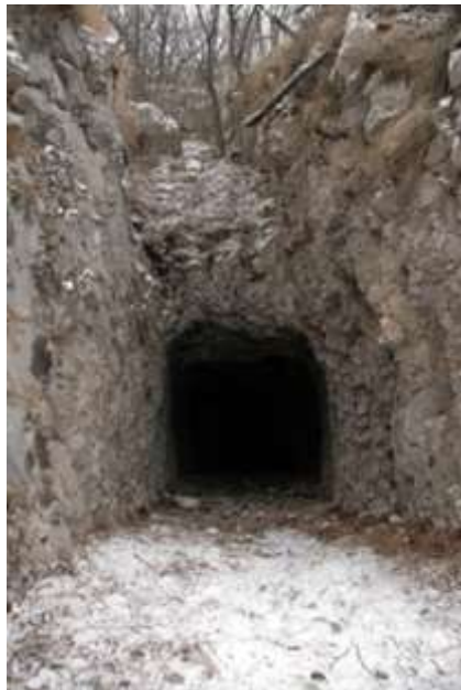
Fig. 43 - Uno dei quattro ingressi che dal trincerano portano all'interno del complesso ipogeo.
