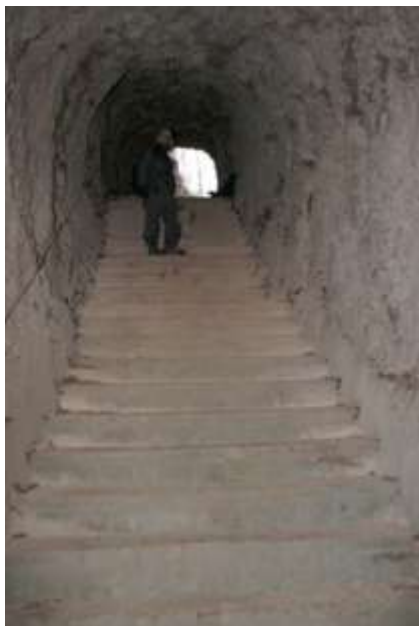
Fig. 42 - La scalinata che porta dall'ingresso sud alla prima batteria in caverna.
