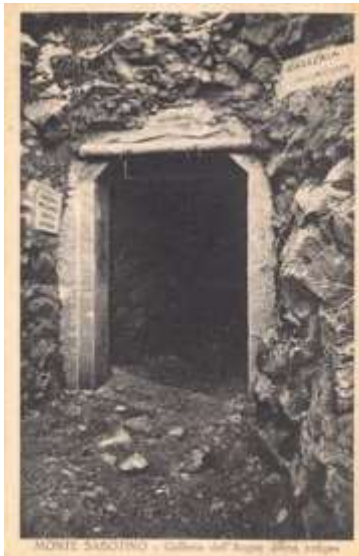
Fig. 22 – Cartolina d'epoca in cui si può vedere come era originariamente l'ingresso della "Galleria dell'Acqua" SA48 (Archivio M. Tavagnutti).
