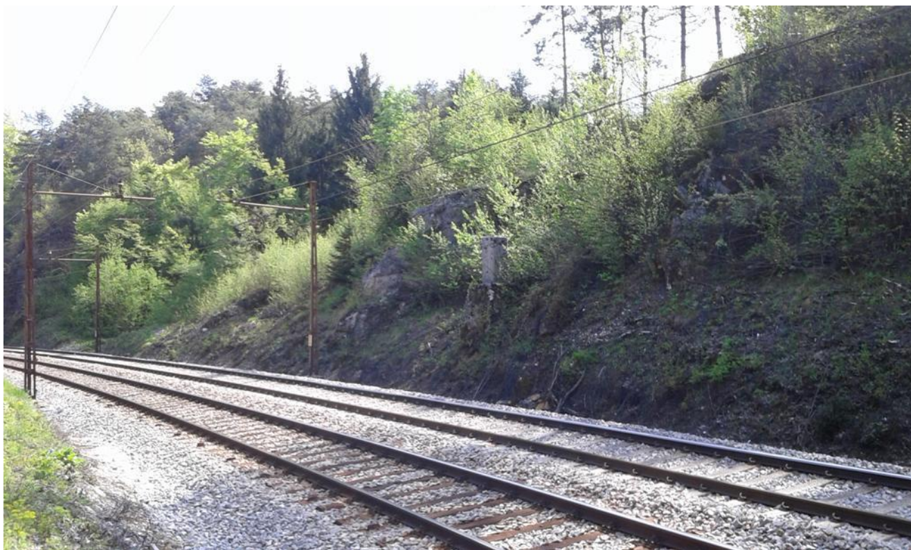
Il C.mil. 50 CXIII si trova sopra la linea ferroviaria Trieste-Postumia-Lubiana di fronte al C.mil. 50 CXII che possiamo vedere nella foto sopra a destra.
