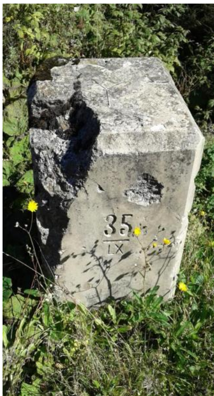
C.mil. di valico 35 LX lungo strada Podlanisce – Sovodenj.
