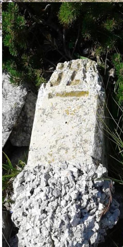
C.sec. 24 III divelto e danneggiato sulla cima del m.te Cora.
