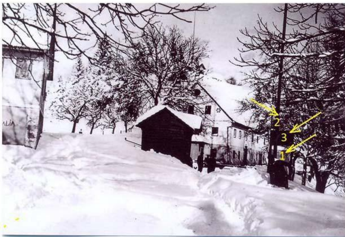
Foto storica del Valico di Trata in inverno. Il cippo 43 di settore che qui si vede indicato con il numero 1 non esiste più, era posizionato vicino alla baracca dalla parte opposta della strada. (Foto archivio Rupnik)
