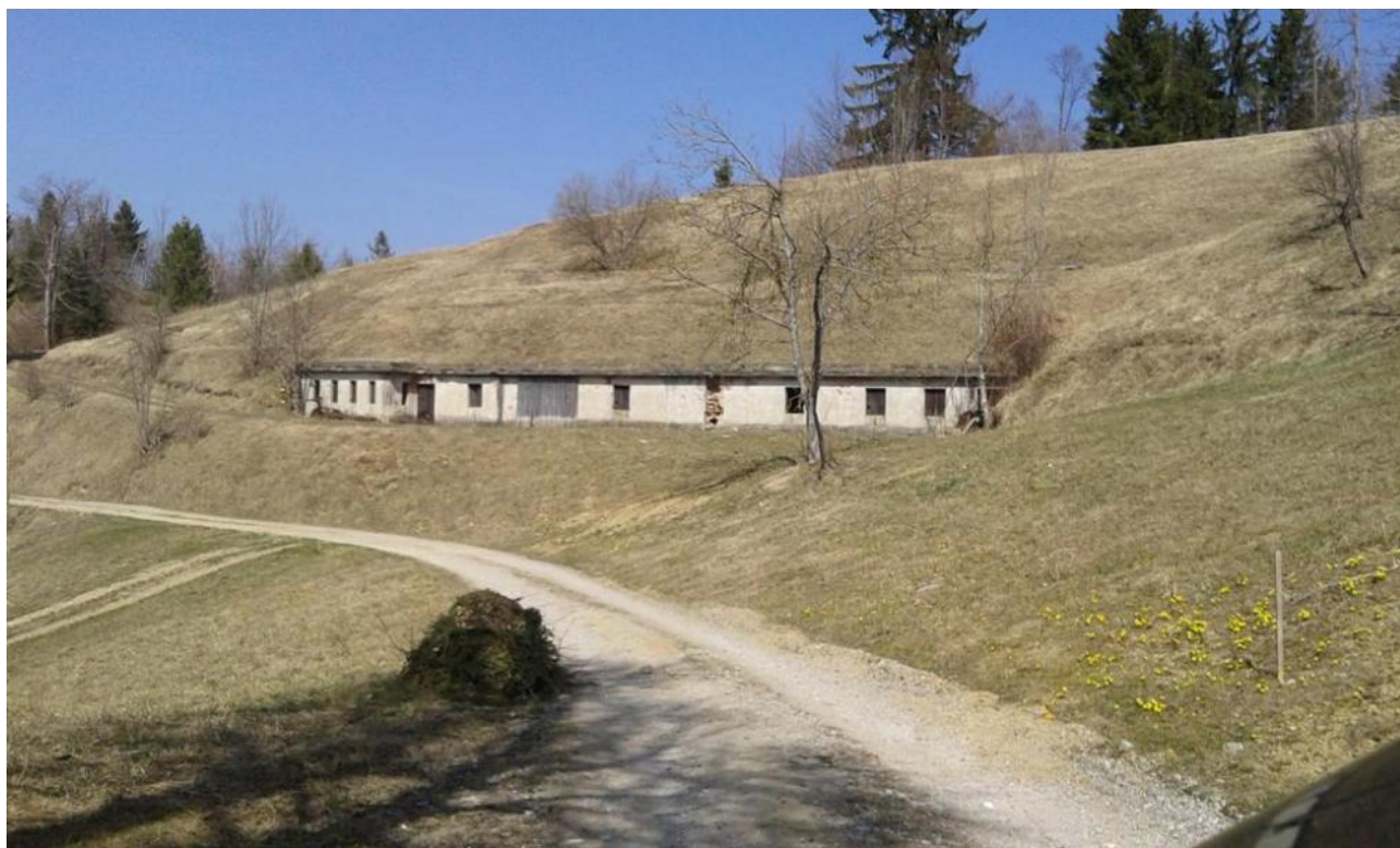
Struttura di molte casermette realizzate dall'Italia in zona Sovodenj - Ziri ecc.
