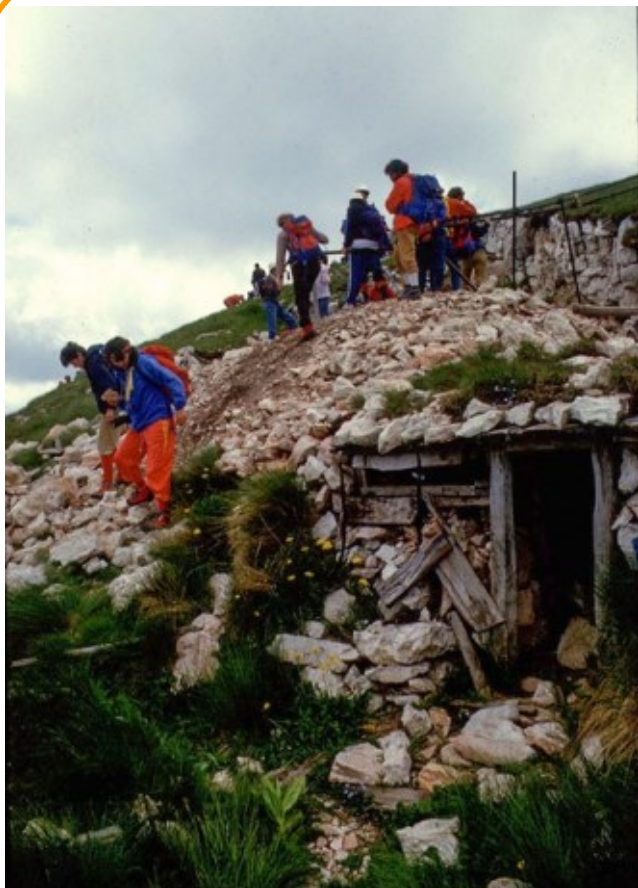
1981 - In tempi recenti sono stati fatti dei tentativi di riapertura dell'ingresso della Grotta della Sibilla dopo che esso era franato.
