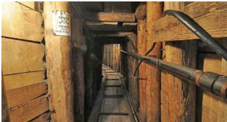
Fig. 49 – Il famoso Tunnel di Sarajevo.
