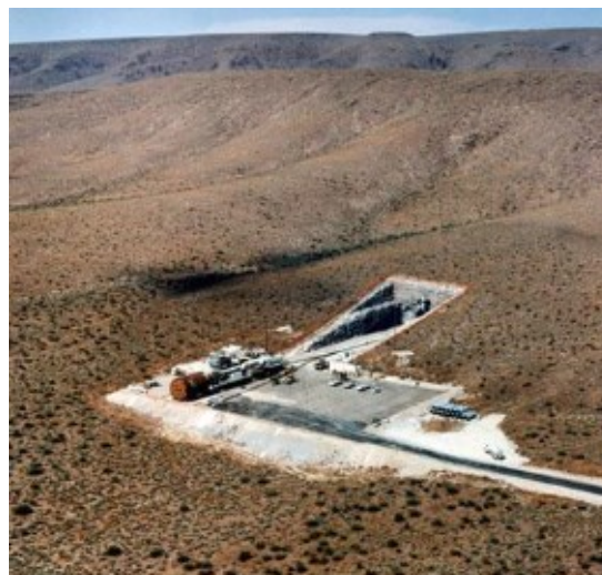
Fig. 100 – Il tunnel d'entrata della DUMB base della Yucca Mountain (USA).
