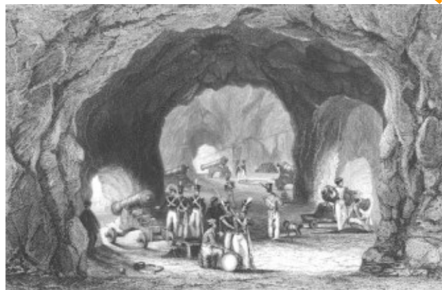
Fig.15 – I tunnel scavati durante il "Grande assedio di Gibilterra" dal sergente maggiore Henry Ince, con i cannoni che battevano il mare (Rock of Gibraltar Great Siege Tunnels Upper Galleries, 1841 Art Print Engraving).
