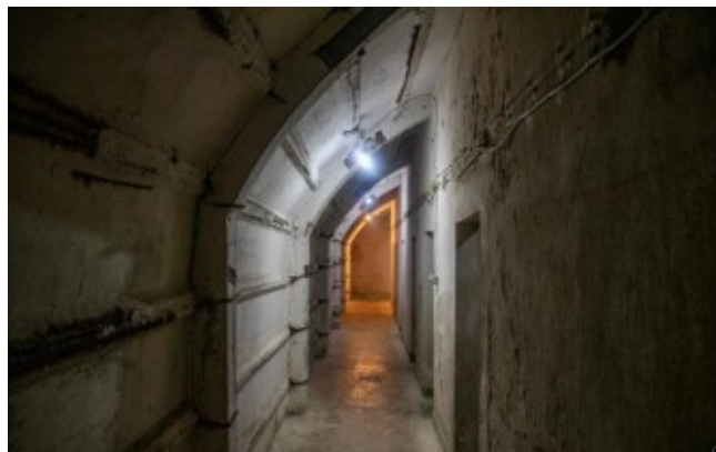
Fig. 13 – Tunnel di difesa realizzato a Gjirokastra (Argirocastro) in Albania durante la "Guerra Fredda" a fronte di possibili invasioni.
