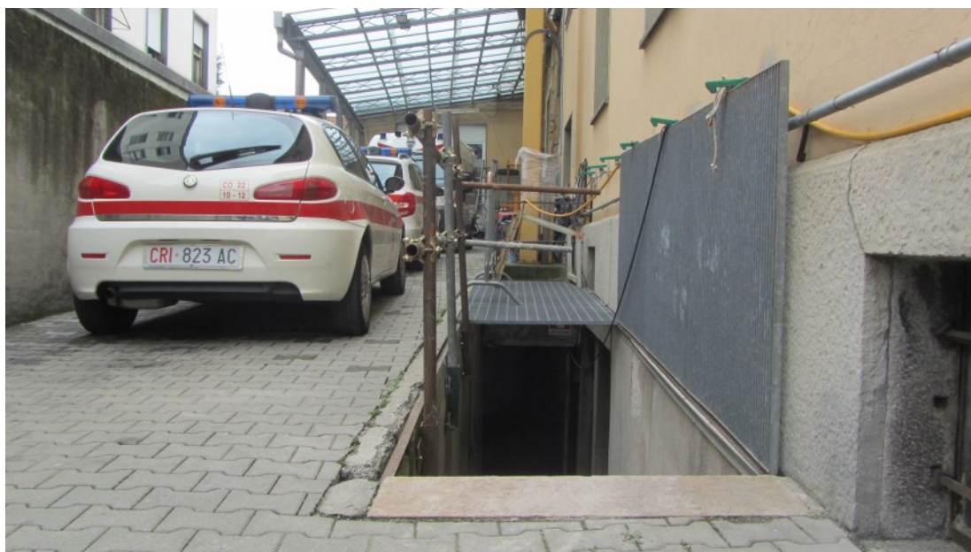
Fig. 5 - Accesso ai locali sotterranei con rifugio antiaereo.
