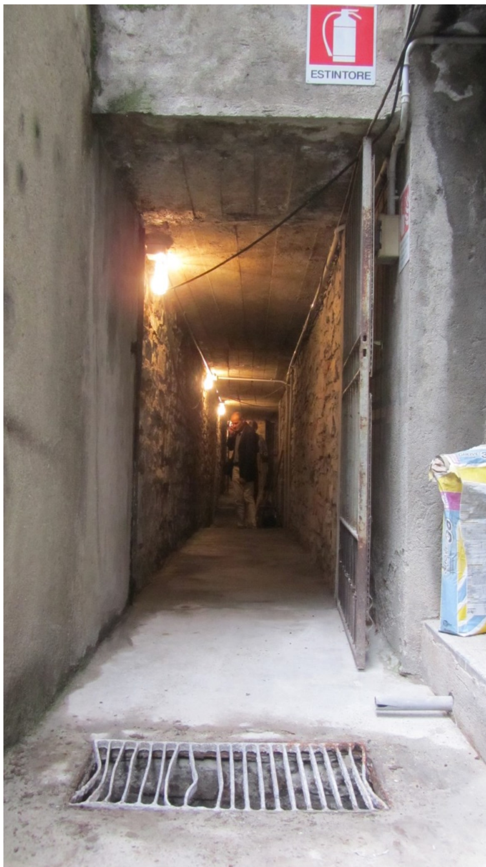
Fig. 6 - Il corridoio che da accesso ai locali sotterranei del rifugio antiaereo.
