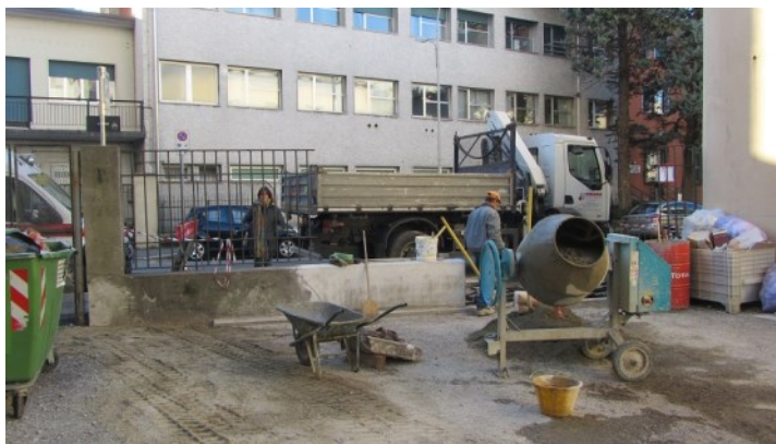
Fig. 2 - Nel 2013 sono stati avviati i restauri della storica sede della Croce Rossa di Como.
