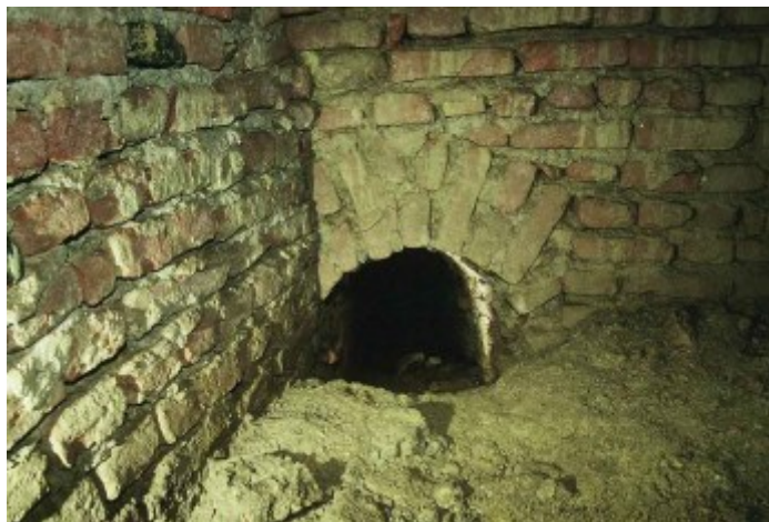
Fig. 40. Contromina nella fortezza di Verrua Savoia.
