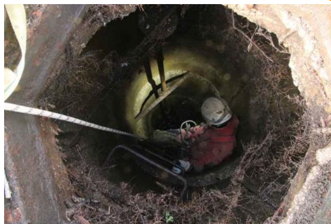
Fig. 49 - Sul fondo del pozzo si intravede lo specchio d'acqua e i resti della tubazione che serviva per il sollevamento dell'acqua.
