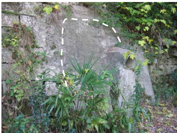
Fig. 83 - Lungo le mura di Gradisca esistevano ancora negli anni '60 degli ingressi d'accesso alle gallerie che si sviluppavano lungo il perimetro murario. Successivamente, in epoca recente, queste sono state chiuse e murate come si può vedere dal tratteggio riportato nella figura qui sopra.
