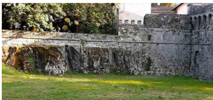
Fig. 86 - In questa figura si vede chiaramente che la cinta muraria prima di raggiungere il Torrione della Campana, poggia sulla viva roccia calcarea.
