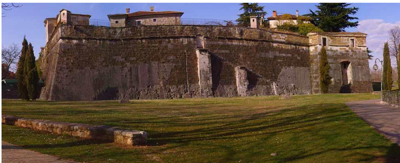
Fig. 99 - Il castello di Gradisca come appare oggi dopo la pulizia delle mura.
