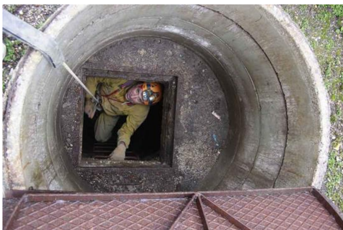
Fig. 30 - L'ingresso del Pozzo dei Frari si trova proprio all'interno della ghiera in pietra posta sopra l'ingresso.
