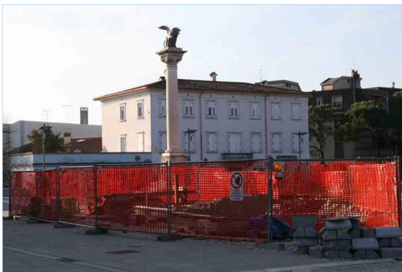
Fig. 98 - Nel 2010 furono eseguiti i lavori per la riqualificazione della piazza. Nel corso degli scavi, per la costruzione della fontana, vennero alla luce i resti delle vecchie mura.
