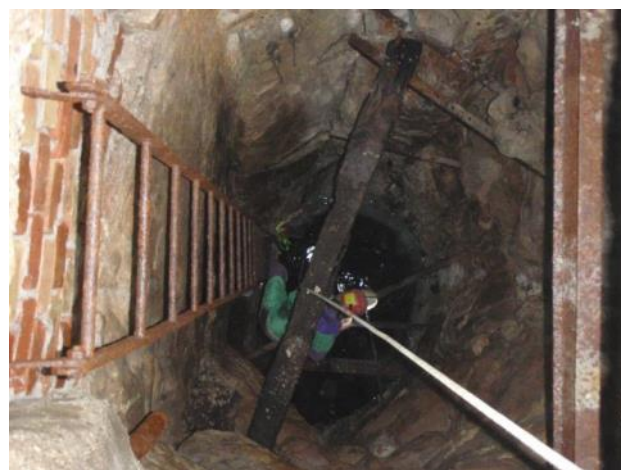
Fig. 31 - Una scala in ferro porta al fondo del pozzo. Rimangono ancora in loco alcune travi che dovevano servire a supportare probabilmente dei pianerottoli indispensabili per chi doveva fare giornalmente la manutenzione delle pompe.
