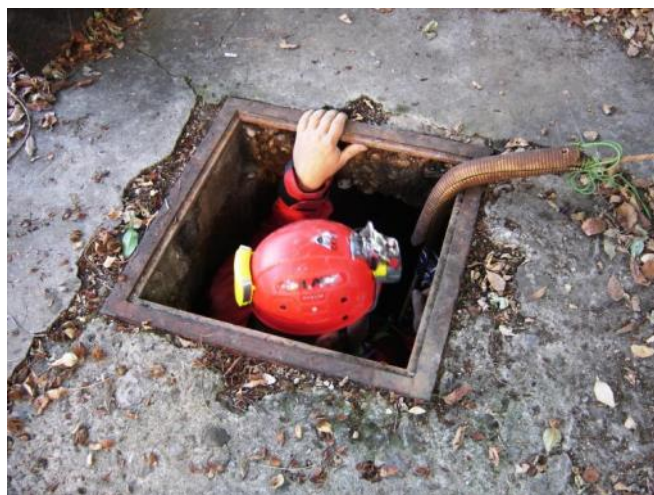
Fig. 37 - Pozzo in Calle Corona. L'imboccatura del pozzo è situata nel giardino di proprietà Verdimonti, laterale a Calle Corona.
