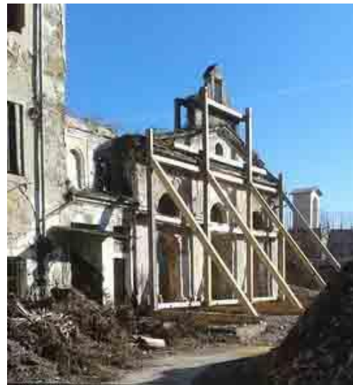
Fig. 115 - Attualmente imponenti lavori di restauro al Castello stanno riportando alla luce diverse bellezze storiche compresa la chiesetta.
