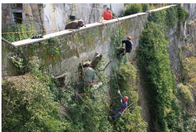
Fig. 68 - Lavori di pulizia delle mura della parte meridionale del Castello eseguiti dal Centro Ricerche Carsiche "C. Seppenhof"..
