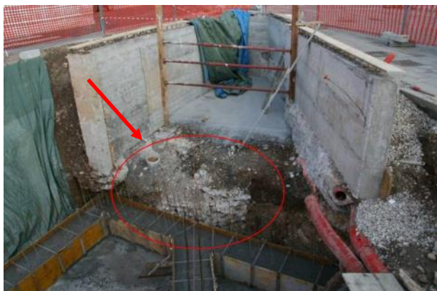
Fig. 2 - Durante i lavori per la costruzione di una fontana nella centrale Piazza Unità d'Italia, vennero alla luce le fondamenta della vecchia cinta muraria della città.
