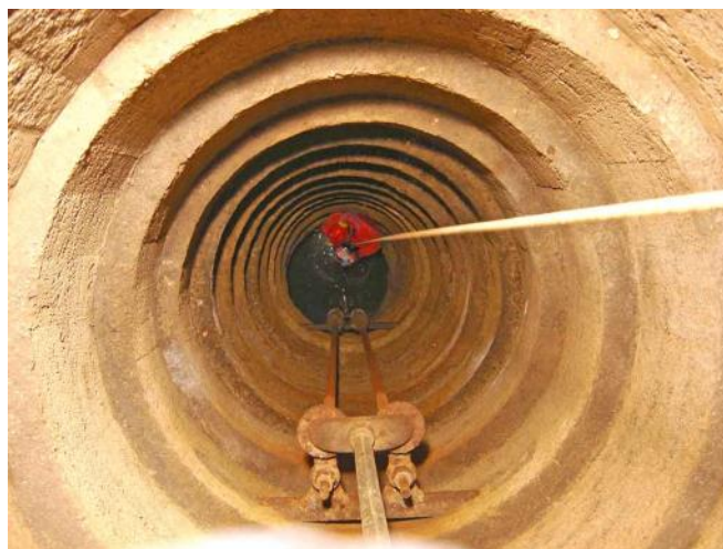
Fig. 39 - Pozzo in Calle Corona. Gli anelli in cemento terminano in corrispondenza del piccolo bacino d'acqua sul fondo. Lateralmente si possono notare i vecchi tubi per il sollevamento dell'acqua.
