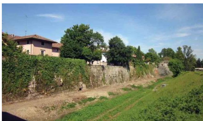
Fig. 121 - Ecco come si presenta oggi la cinta muraria di Gradisca dopo i lavori di pulizia.
