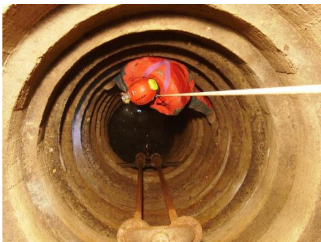
Fig. 38 - Pozzo in Calle Corona. Qui si possono vedere molto bene gli anelli di cemento che costituiscono l'ossatura di rinforzo del pozzo.
