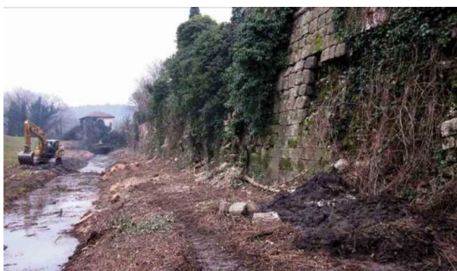
Fig. 118 - Il lavoro di pulizia e ripristino delle parti murarie è stato notevole.
