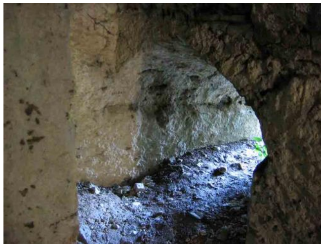
Fig. 97 - Torrione della Spiritata, l'interno della galleria.
