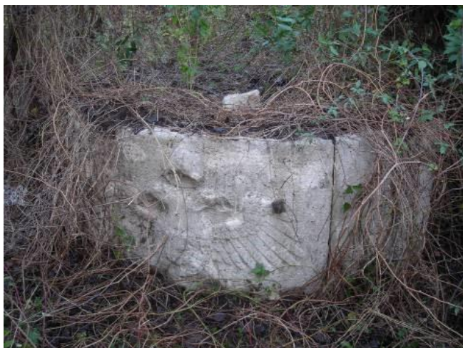
Fig. 41 - La ghiera del pozzo che si trova nel cortile interno del castello.
