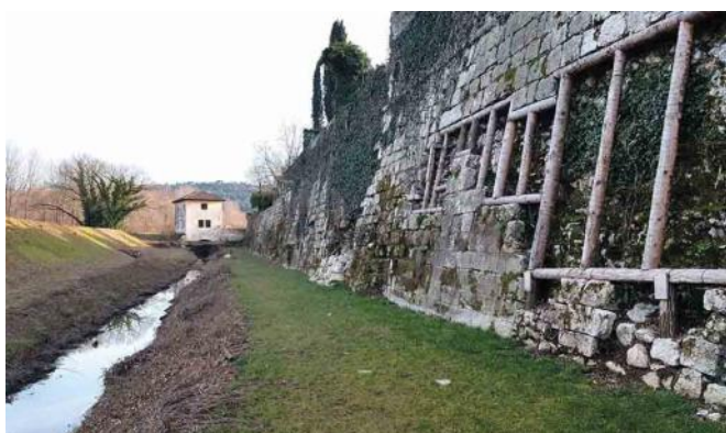
Fig. 119 - In alcune parti delle mura sono stati fatti lavori di consolidamento.
