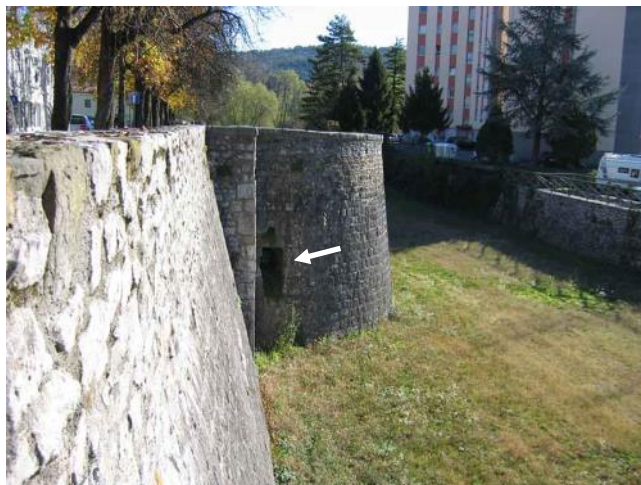
Fig. 92 - Il Torrione della Calcina visto dal lato N-O in cui si vede la seconda apertura della galleria.
