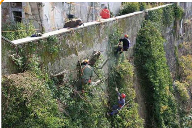
Fig. 100 - Prima del nostro intervento le mura del Castello erano invase dal verde che ne occultava gran parte della struttura.
