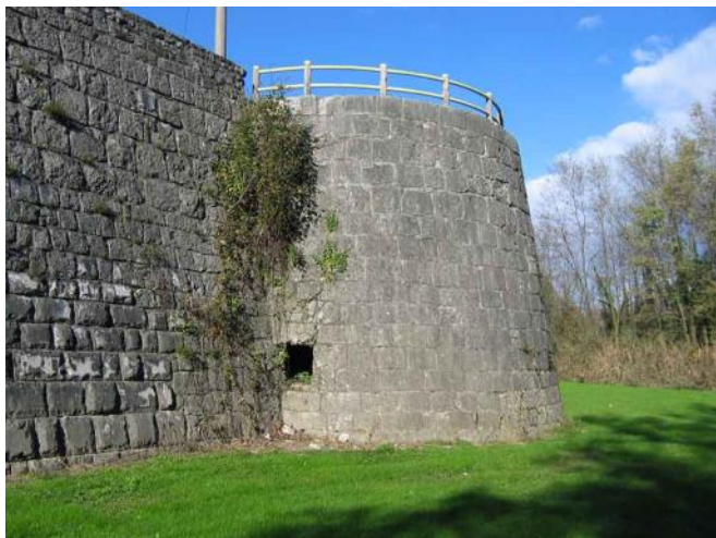
Fig. 96 - Torrione della Spiritata in cui si vede l'ingresso di una breve galleria attualmente chiusa da crolli.
