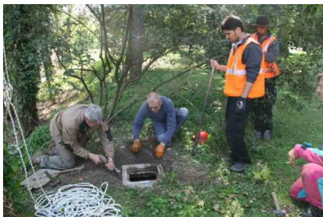
Fig. 50 - Gli operai del Comune intenti a togliere la botola in cemento per permettere agli speleologi l'ingresso al pozzo.
