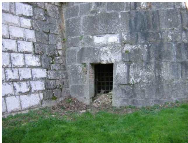
Fig. 73 - L'ingresso al Torrione San Giorgio è chiuso da una robusta grata in ferro. Saltuariamente le piene del vicino Isonzo allagano il piano basso del torrione e i materiali trasportati dal fiume ostruiscono l'accesso.
