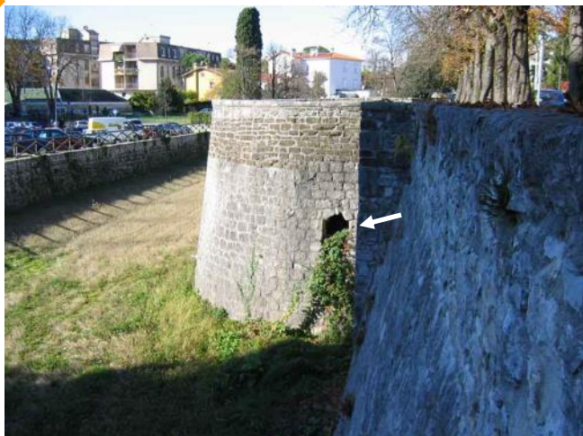
Fig. 91 - Il Torrione della Calcina visto dal lato S-E in cui si vede un'apertura della galleria.
