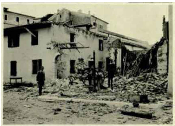
Fig. 25 - Qui si vede la pompa dell'acqua in Campiello Emo, dopo un bombardamento. Sul retro, si riconosce l'edificio danneggiato che è l'attuale officina Venturoli, durante la Prima Guerra Mondiale. A sinistra s'intravede il castello (coll. Renato Radolli).
