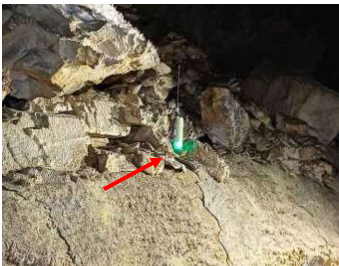
Un nodo della rete Mesh, indicato dalla freccia, installato in grotta (foto M. Abisso).
