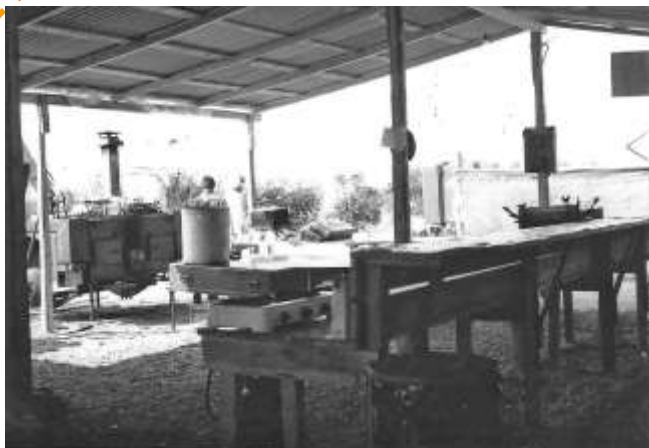
“Base Artegna” – Posto cucina del “Campo n. 5” costruito dai reparti della Brigata.
